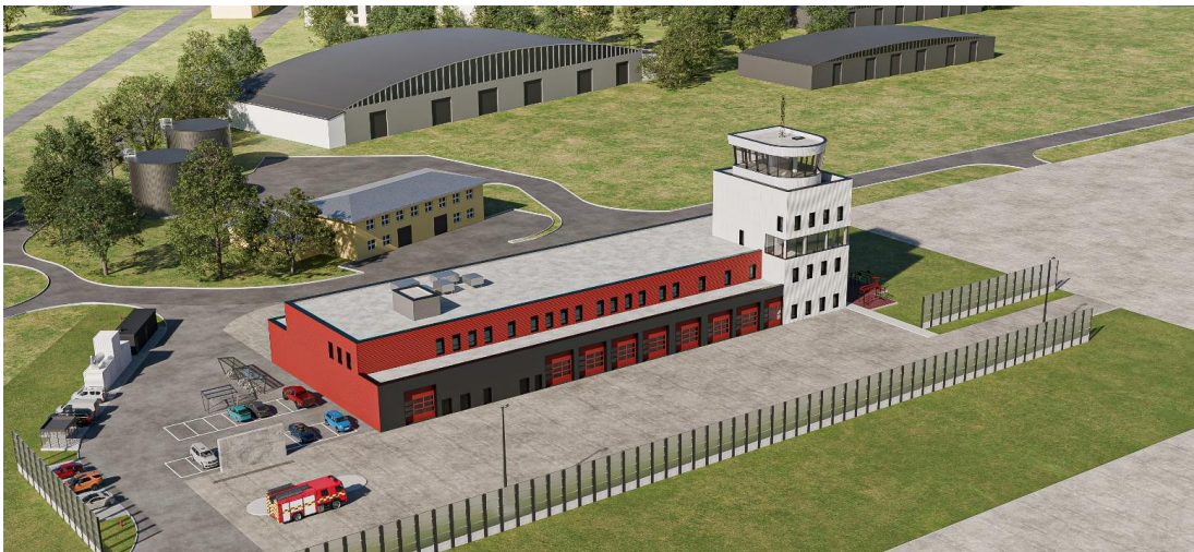
Die PORR setzt die erste Bauphase des Aerial Port of Debarkation (APOD) am Flughafen Wrocław-Strachowice um © RZI
