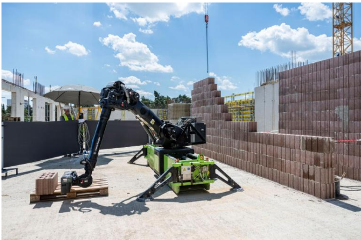
„Walter“ kann Ziegel mit einem Gewicht von bis zu 52 kg heben © PORR/Jan Hrdý
