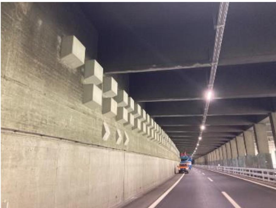
Abbildung 2: Ankerkopfsanierung
